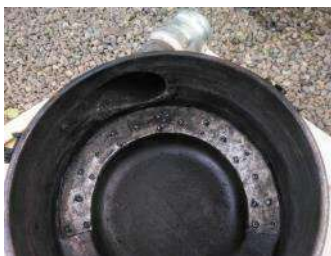
Los agujeros de entrada de aire original taponados y el nuevo caño de entrada tangencial soldado.
